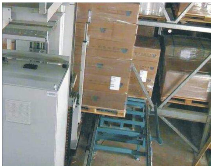
Regalbediengerät nimmt eine Palette zur Einlagerung auf
